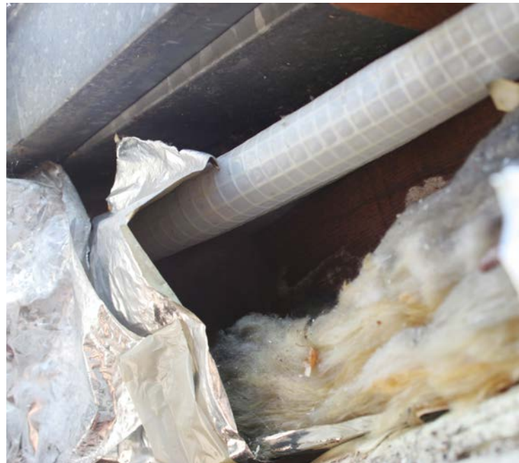
Mineralfasern als Dämmstoff: Material, das bis 1996 verwendet wurde, ist krebserregend. Bis Juli 2000 verbaut, gelten die Fasern ohne Nachweis zumindest als krebverdächtig.
